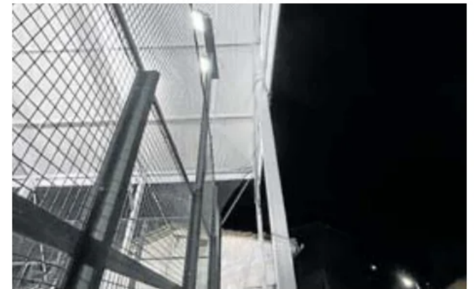
La nueva red instalada en la pista de pádel municipal. UDALA
