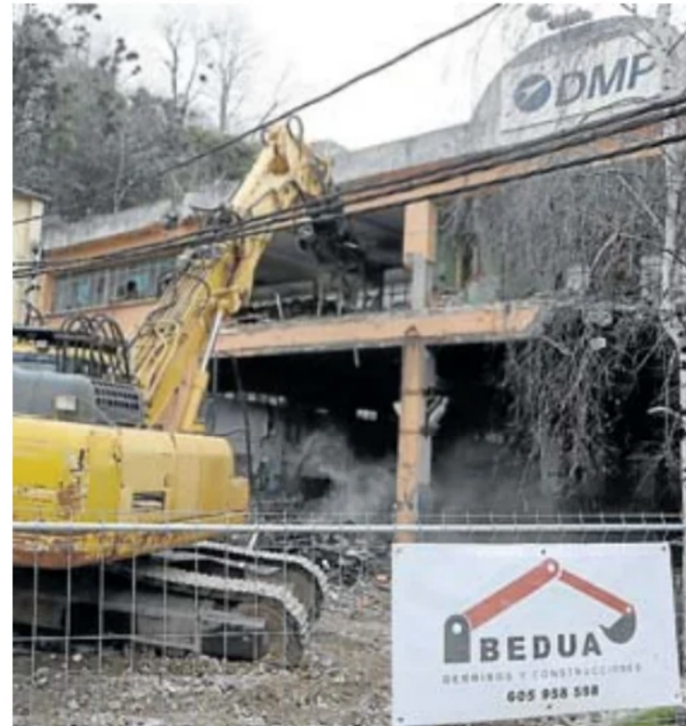
Un excavadora durante las labores de derribo, ayer por la mañana. LEON
