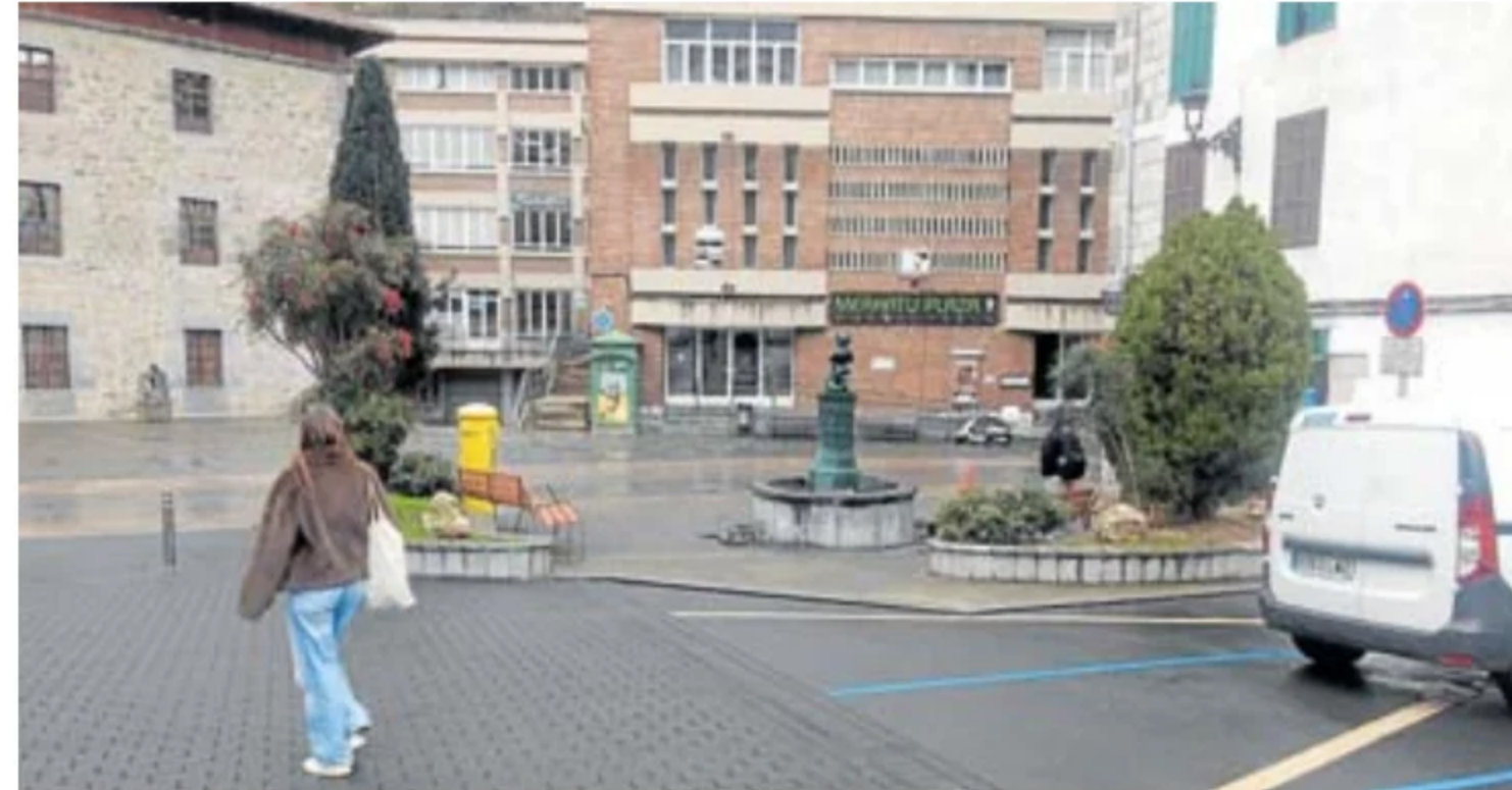
Una joven pasa por la zona en la que se va a soterrar el centro de transformación eléctrica. LEON
