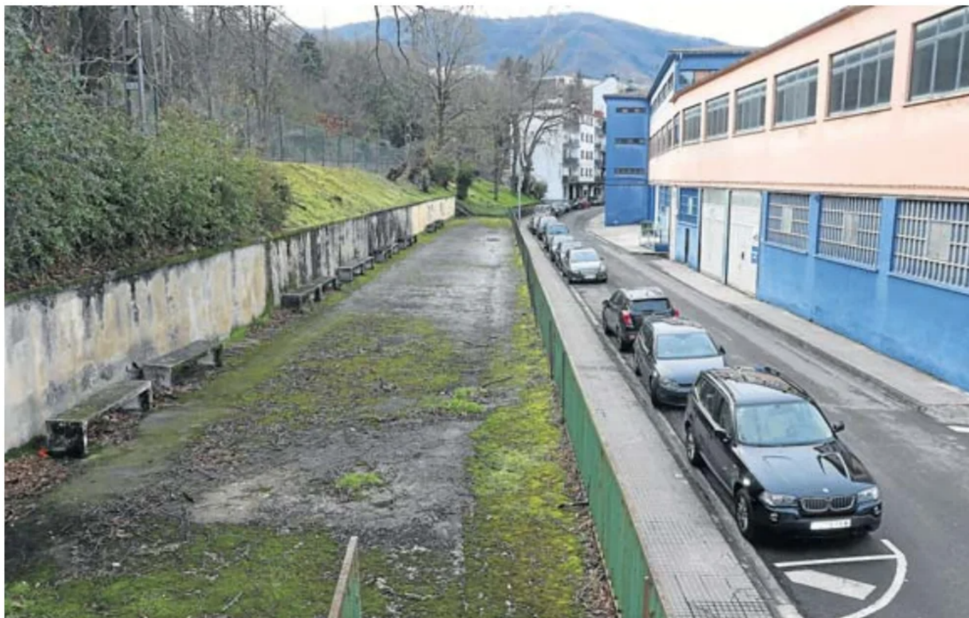
Vista general de la infrautilizada explanada elevada, que se eliminará para reurbanizar el entorno, ampliando la acera y creando una plazoleta. J. LEON
