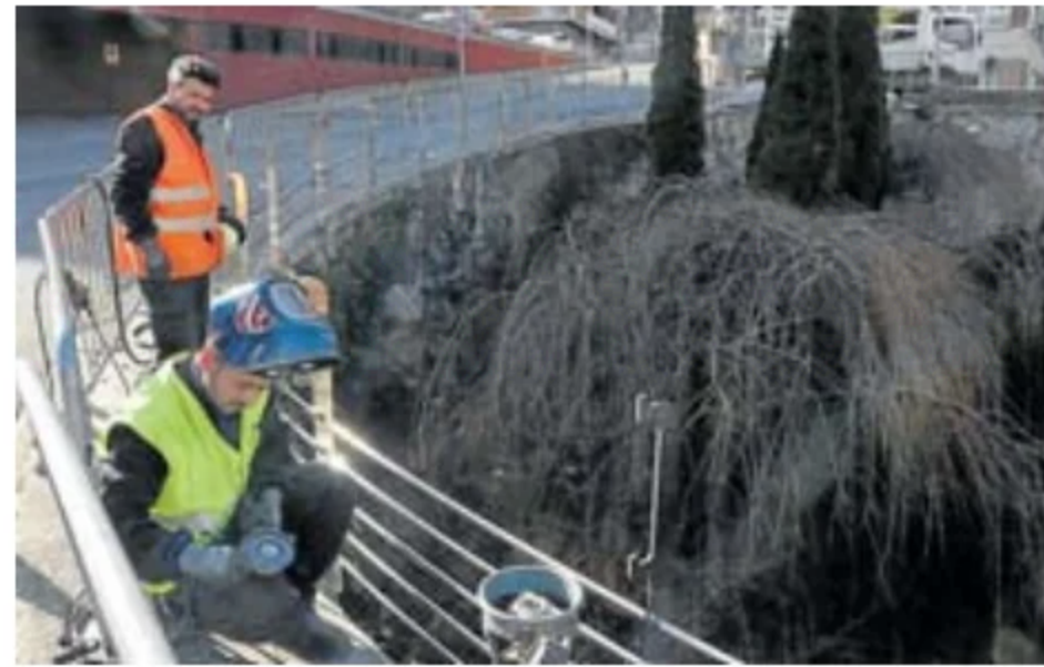
Dos operarios trabajando en la reposición de la barandilla. J. LEON
