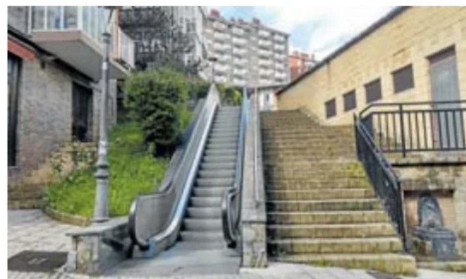
Tramo de escaleras mecánicas en Urazandi. LEON
