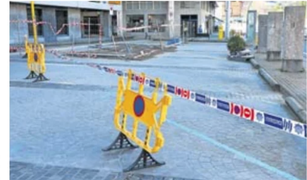
Gudarien Plaza, precintada para posibilitar la ejecución de las obras. LEON
